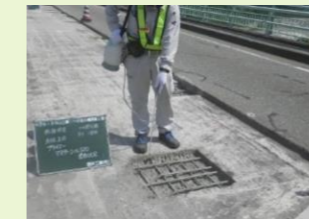
プライマー(接着剤)塗布
