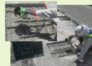
鉄筋防錆処理
