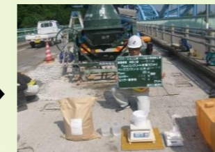
速硬コンクリート製造
