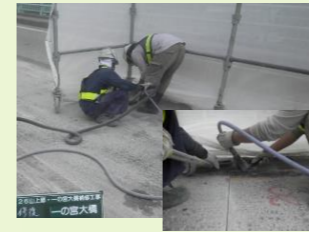
コンクリート切断
