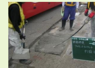
速硬コンクリート製造
